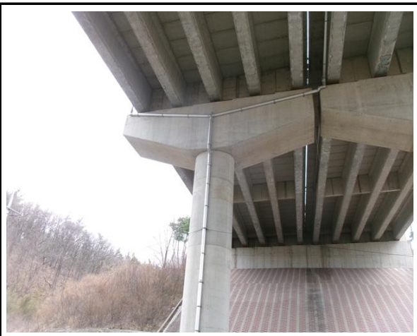
위 치 배수시설 현 황 배수관 전경
