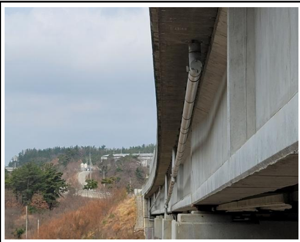
위 치 배수시설 현 황 배수관 전경
