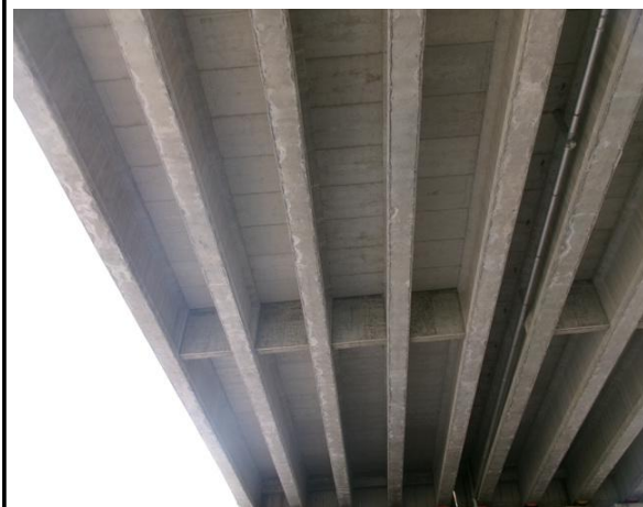
위 치 주형 (바닥판하면) 현 황 전경
