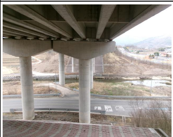
위 치 교각 현 황 전경
