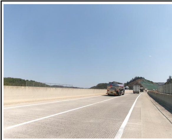
위 치 교면포장 현 황 전경
