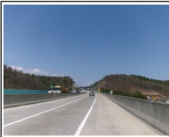
위 치 교면포장 현 황 전경
