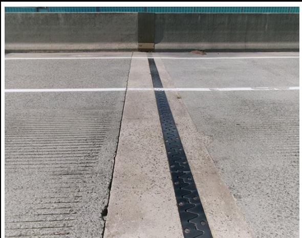
위 치 신축이음 현 황 전경
