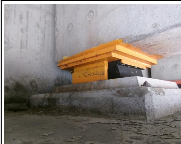
위 치 교량받침 현 황 전경
