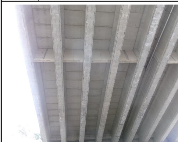
위 치 주형 (바닥판하면) 현 황 전경
