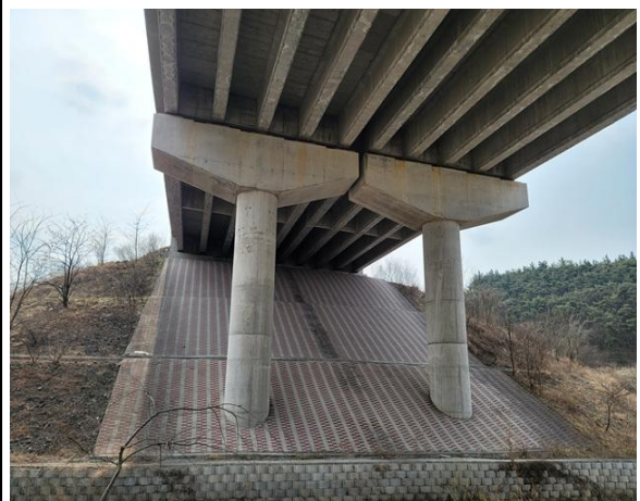
위 치 교각 현 황 전경
