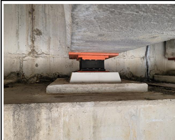
위 치 교량받침 현 황 전경
